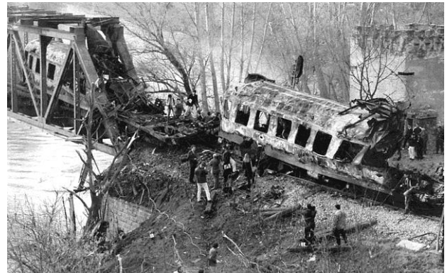
Nach zwei Nato-Angriffen am 12. April '99: ausgebrannter Zug auf der Morava-Brücke bei Grdelica
